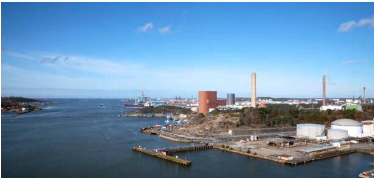
Figur 4-15. Vy från sydväst som visar befintligt utseende med Göteborg Energis beslutade (men ej uppförda) bioångpannan inkluderad i bilden Bilaga B.08.02 Kulturmiljöutredning.
